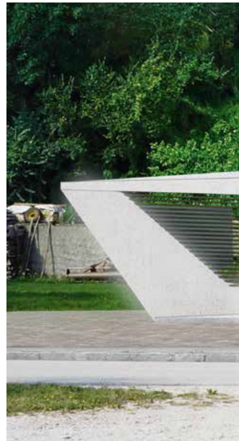
Talstation Aggsbach Dorf
