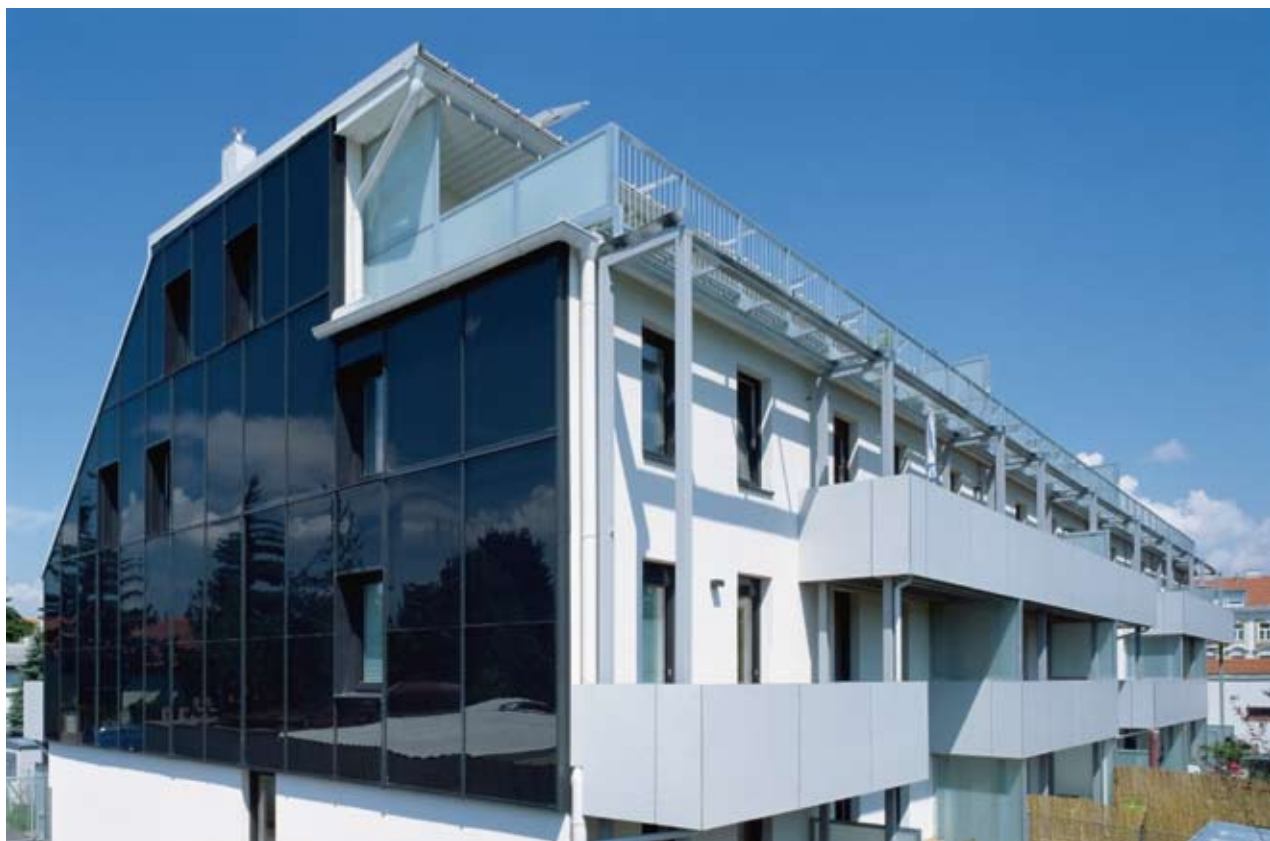
Süd-Ost-Ansicht mit vertikalem thermischen Kollektor im Süden
