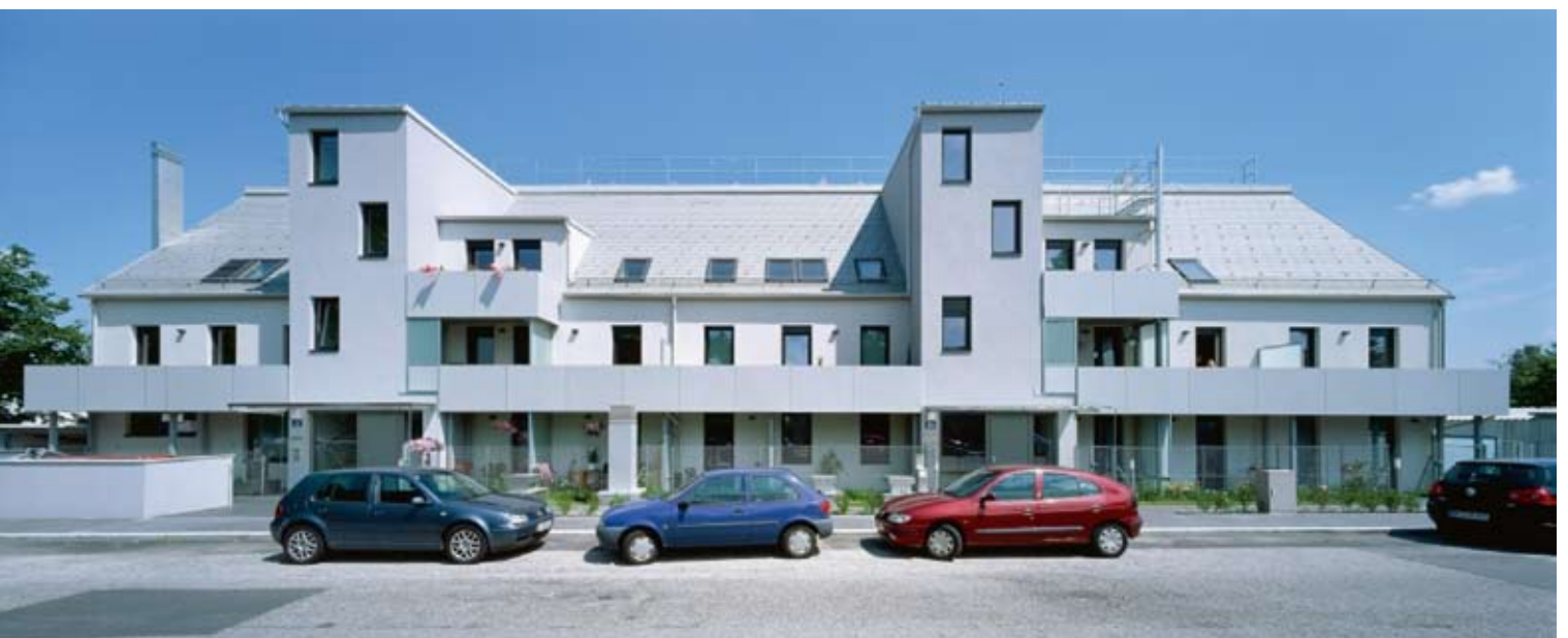
Wohnanlage von der Straßenseite
