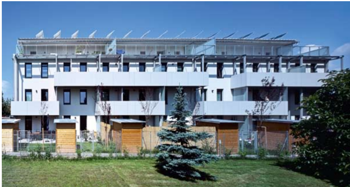
Ostfassade mit auf dem Dach aufgeständerten PV-Elementen
