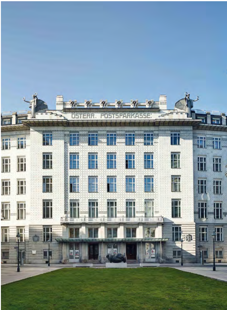
Österreichische Postsparkasse, ein Kulturbau, alle Decken und Stiegen wurden bereits aus armiertem Beton errichtet: Der Bau von Otto Wagner wird nun von der BIG zur neuen Heimat für Kunst und Wissenschaft umgestaltet – seit 2. Juni ist das Otto-Wagner-Museum in der PSK wieder geöffnet.
