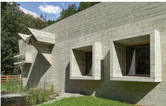
Bretterschalungsbild eine zwischen Fels und Holz assoziierende Rolle einnimmt. Für die Beheizung des Gebäudes kommt eine Luftwärmepumpe zum Einsatz. Das Gebäude wurde in Stahlbetonmassivbauweise errichtet, die Außenwände sind hochwärmegedämmt. Das Niederschlagswasser des Daches wird über einen Wasserspeier in einem Biotop gesammelt, welches auf das zentrale Thema Wasser für den Ort Längenfeld verweist.
