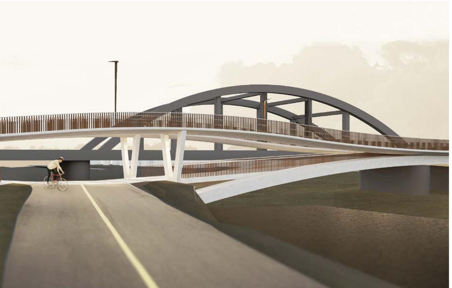
die Lasten zufolge der Abfahrtrampe auf und dienen als Auflager für die Spannbänder zur wirkungsvollen Halbierung der Spannweite der maßgebenden Felder. Die Bogenform ermöglicht eine starke Reduktion der Querschnittsgeometrie. Mit der Konstruktion wird eine hohe Ressourceneffizienz der Gesamtkonstruktion erreicht, die Schlankheit verstärkt den Eindruck der Linearität in der Ansicht.
