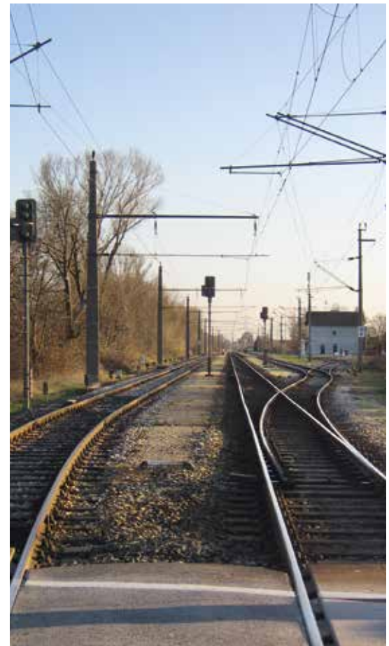
Ausgangssituation: Der Istzustand des Bahnhofs Münchendorf
