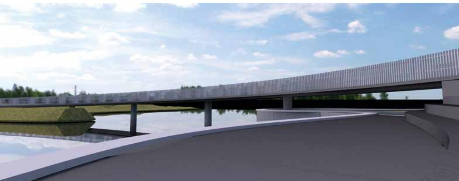
Die vorhandene Geländesituation mit den relativ ungleichen Anschlussbereichen, der schroffen Böschung am Nordufer sowie dem flach fallenden Uferweg neben dem städtischen Angelbad auf der anderen Seite forderte die Entwicklung eines unsymmetrischen Tragwerks, das sich neben der Erfüllung der technischen Anforderungen außerdem in der Umgebung des städtischen Naherholungsgebietes zurücknehmen sollte.
