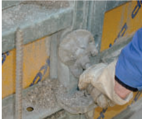
Abb. 24: Zu breite Elemente und zu kleine Ankerplatte
