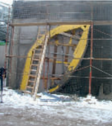
Abb. 23: Vor dem Betonieren
