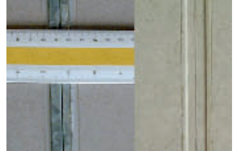
Abb. 13: Saubere Elementstöße (Schalung – Beton)
