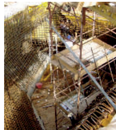
Abb. 31: Seebad Kaltern, Bewehrung
