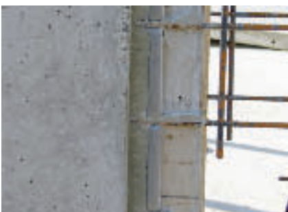
Abb. 16: Sauberer Abschluss mit Dichtsnur
