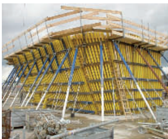
Abb. 27: Eingerichtete Schalung, Phaeno Science Center, Wolfsburg Fotos: © Doka GmbH
