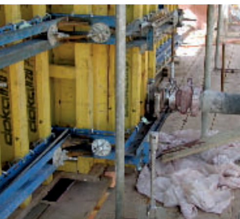
Abb. 19: Einbringen durch Einfüllstützen
