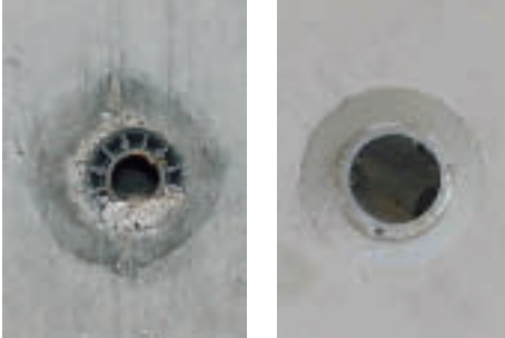
Abb. 11: Ankerloch unabgedichtet / abgedichtet Fotos: © Doka GmbH
