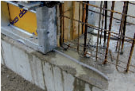
Abb. 14: Abdichtung mit Dichtsnur im Aufstandsereich
