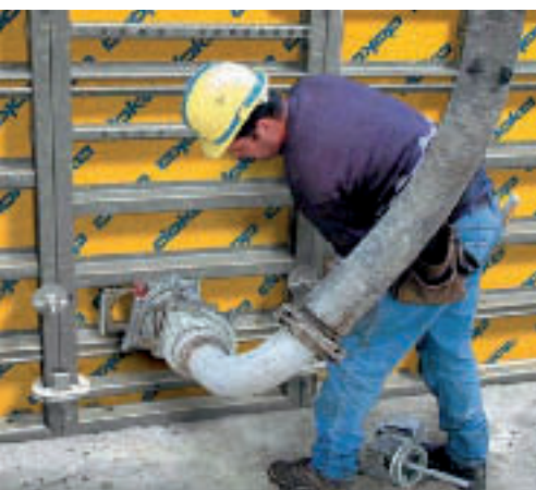
Abb. 20: Einfüllstützen in der Systemschalung integriert Fotos: © Doka GmbH
