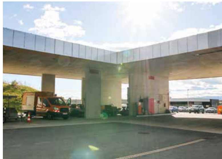
Tunnelwarte Hausmannstätten, geplant von Architekt Dietger Wissounig
