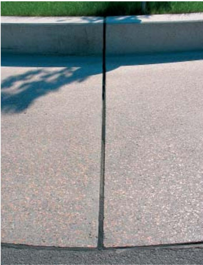
Kreisverkehr Dornbirn-Rohrbach – Fugendetail: Gestaltung durch farbige Zuschlagstoffe und Schleifen, Fugenausbildung
