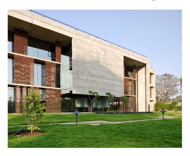
Sichtbeton, viel Grün und die Nutzung der Wärmeleitfähigkeit von Beton sind die Merkmale des Bürobaus in Indien.
