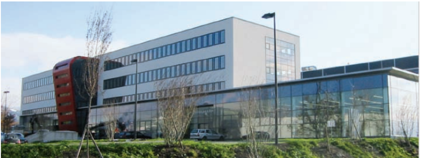
Südwestansicht mit Bürotrakt und Abholmarkt
