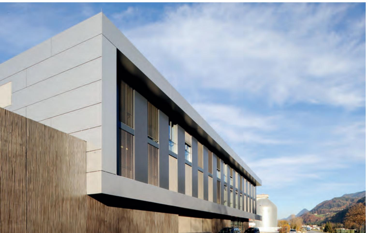
Abschottung der Werkstätten und Lagerbereiche gegenüber der Straße wurde durch eine 142 Meter lange, dunkel anthrazit gefärbte und strukturierte Stahlbetonwand entsprochen.
