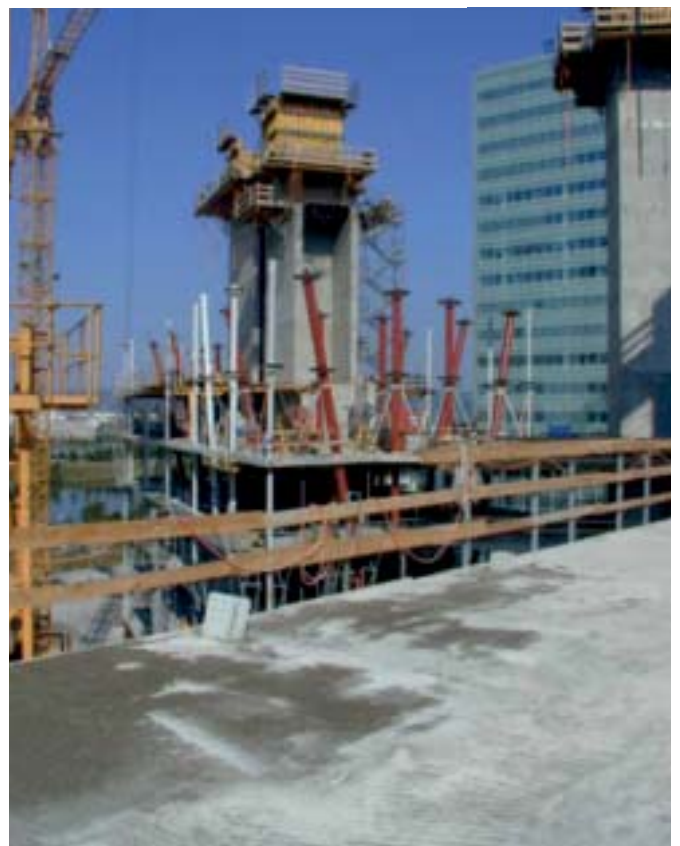
Bild 9: Bauzustand des räumlichen Tragwerkes. Die roten Elemente sind die druckkraftbeanspruchten Stahlverbundstützen. Im Fassadenbereich stehen jeweils zweigeschoßig die im fertigen Zustand als Zugelemente wirkenden weißen Vollstahlfassadenhänger, im abgebildeten Bauzustand sind diese Elemente jedoch druckbeansprucht.
