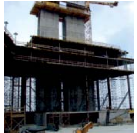
Bild 8: Bauzustand des bis zu 17 m hohen Luftraumes, unterstellt mit leichter Flächenrüstung sowie der schweren Raumrüstung. Letztere musste bis zur Tragwerkskomplettierung vorgehalten werden. Im fertigen Zustand erfolgt die Kraftabtragung nur mehr über den Stiegenhauskern, die realisierten freien Auskragungen bis 22 m sind auf diesem Bild bereits deutlich erkennbar.
