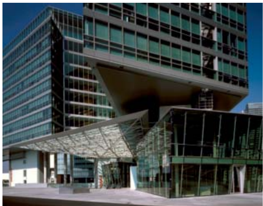
Bild 3: Im Vordergrund rechts Kristall 3 mit Geschäfts- und Sondernutzung, links die 750 m 2 große Eingangsüberdachung des Hauptzuganges, oberhalb die „schwebenden“ Bürogoschoße
