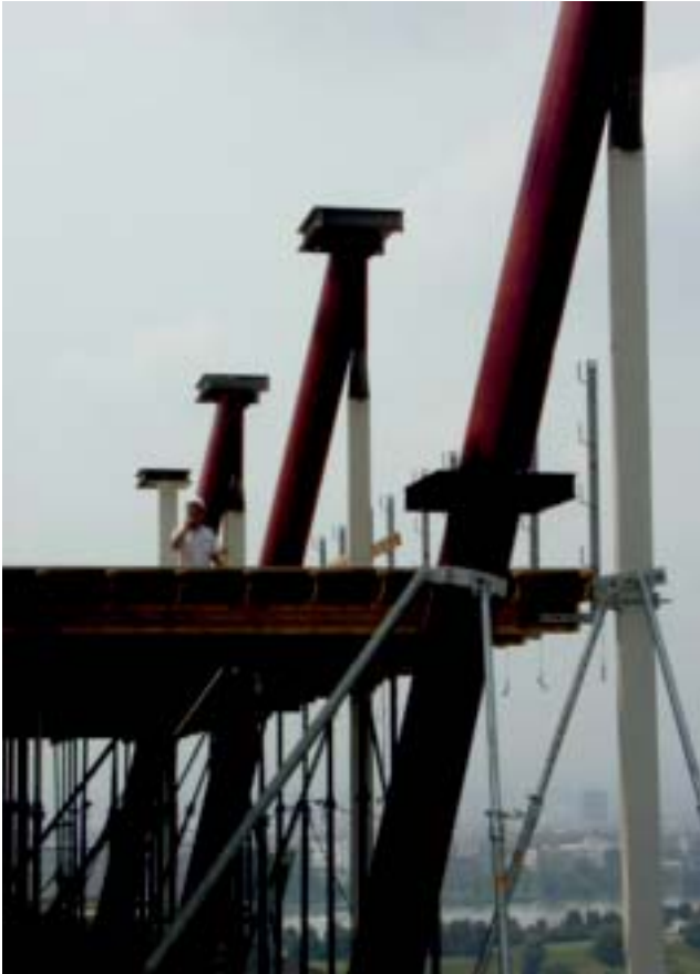
Bild 10: In der Deckenebene über 11. OG werden die Fassadenhänger mit den Druckstützen kraftschlüssig verschweißt, nun sind noch die aussteifenden Betondecken zur Komplettierung des Tragwerkes herzustellen.
