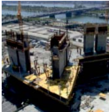
Bild 7: Baustellenübersicht nach Fertigstellung der ersten Geschosßdecke unter 4. OG bzw. Beginn der Arbeiten an der Decke unter 5. OG. Zentral sind die drei lastableitenden Stiegenhauskerne sowie die ersten Elemente der räumlichen Tragkonstruktion zu erkennen.
