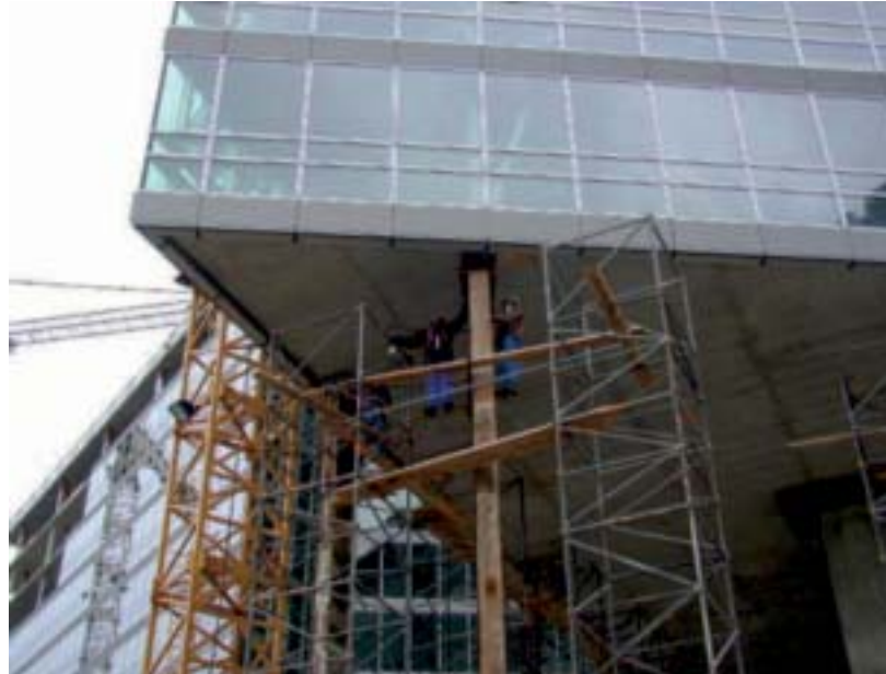
Bild 11: Nach Aushärtung der Decke über 11.OG kann auch die schwere Raumrüstung ausgebaut werden. Die Kraftumlagerung auf das definitive Tragsystem erfolgt durch Absenken des am Kopfes des Stahlträgers befindlichen Sandtopfes. © Strabag
