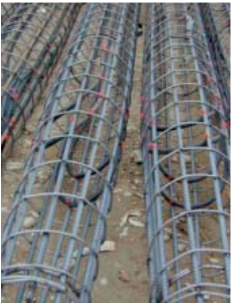
Bild 5: Spitzen der Bewehrungskörbe der 17 m langen SOB-Pfähle mit eingelegten Kunststoffrohren
