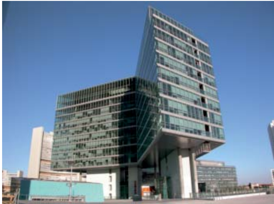
Bild 1: Gesamtansicht-Standpunkt Höhe Erdgeschoß von der A22-Überplattung aufgenommen. Im Hintergrund links die UNO-City, rechts hinten das Tech Gate Vienna. © Strabag
