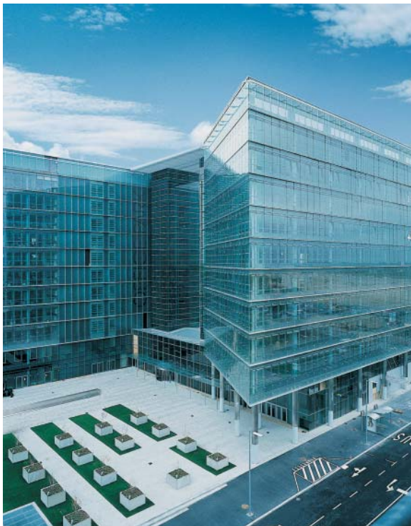
Office Park Flughafen Wien, Foto: Wicona
