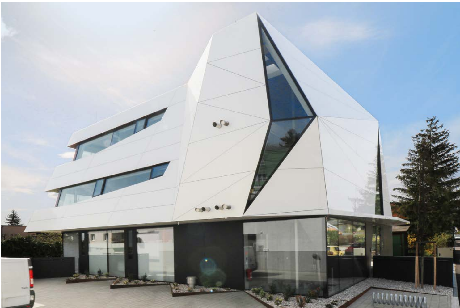
Blickfang aus Beton – inklusive Nutzung aller Vorteile des Baustoffes: eine Kinderarztpraxis mit drei Wohnungen in Perchtoldsdorf.
