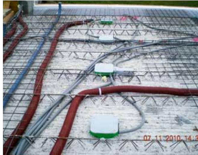
... darauf die untere Bewehrungsebene, danach werden die Rohre für die Bauteilaktivierung verlegt und schließlich alle Leitungen verlegt (Wasserzu- und -ableitung, Grund- & Regelheizkreis, Elektroleitungen). Anschließend wird betoniert, und damit ist die 30 cm hohe Fundamentplatte fertig.
