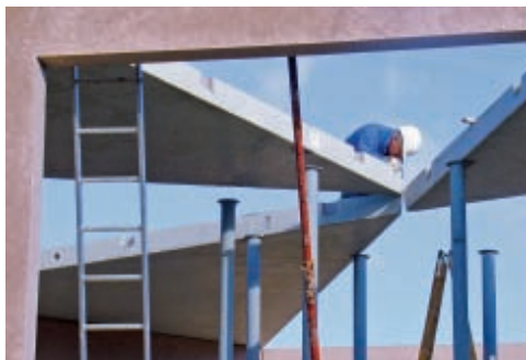
Bild 6: Punktgenaues Zusammenfügen der Deckensegmente
