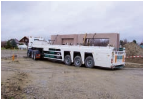
Bild 4: Anlieferung der massiven Fertigteile
