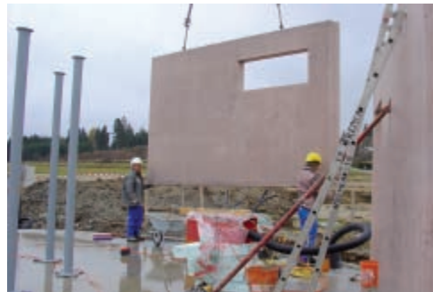
Bild 5: Versetzen der Wandelemente
