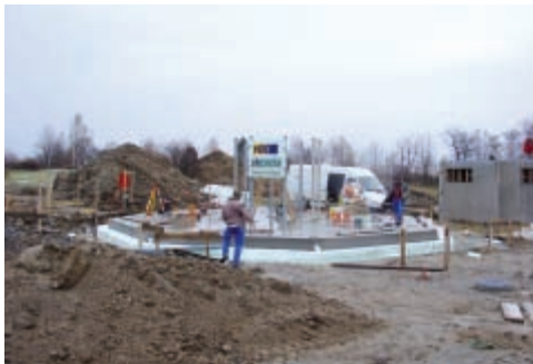
Bild 3: Entstehung Fundamentplatte
