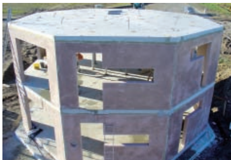
Bild 7: Fertiger Rohbau nach nur 2 Werktagen
