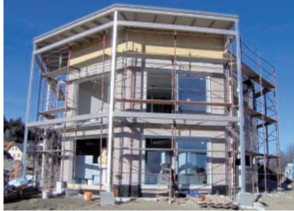
Bild 10: Eingebaute Fenster- und Türelemente
