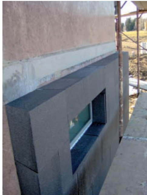
Bild 8: Passivhaus-Wanddämmung
