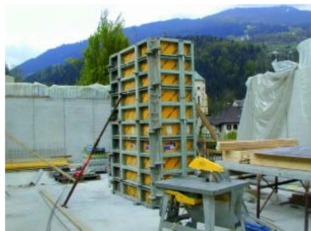
Schalung des Kamins
