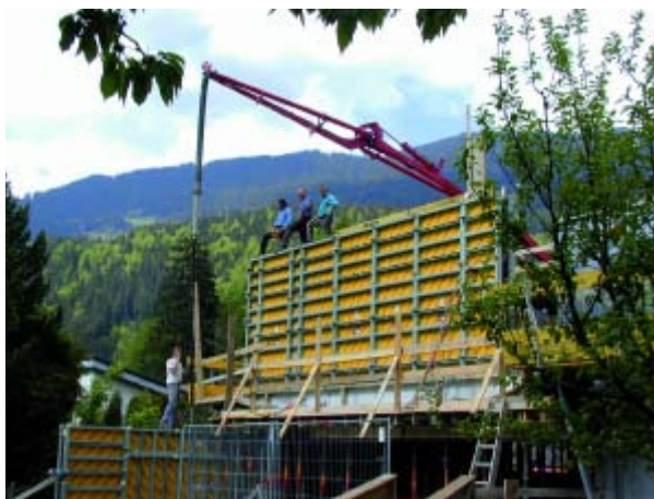
Errichtung der Obergeschosswände
