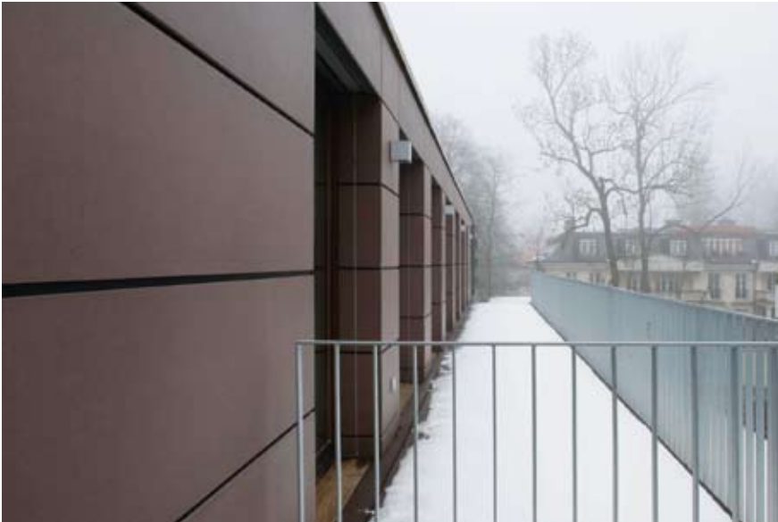
Die Platten sind von außen unsichtbar befestigt.
