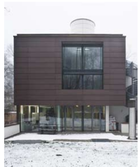
Gleich einer Haut aus Beton zieht sich concrete skin über das gesamte Gebäude.
