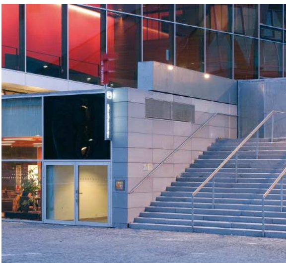
Stadthalle Wien – stairWays, silbergrau
