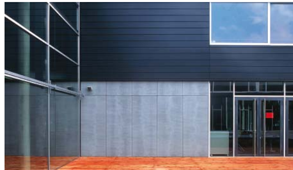
Hauptschule Kolbermoor – 700 m 2 concrete skin, silbergrau ferro
