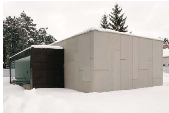
Stadtfriedhof Linz – 200 m 2 concrete skin, elfenbein matt
