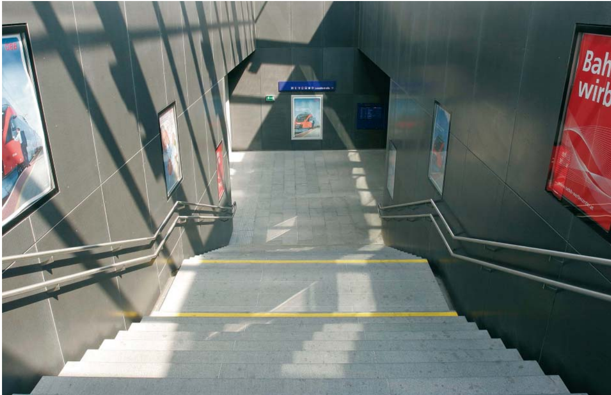
Nordbahnhof Wien – 1.800 m 2 concrete skin, liquide black, ferro light und anthrazit matt
