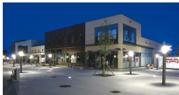
Outletcenter Leoville – 1.500 m 2 concrete skin, grün ferro, liquide black ferro, sandstein ferro, silbergrau ferro
