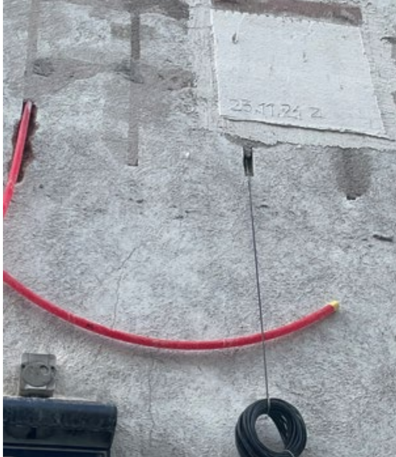
Die Leitungen werden direkt in die Fassade gelegt.
