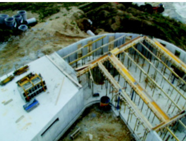
Der Betonbau vom Kran aus
