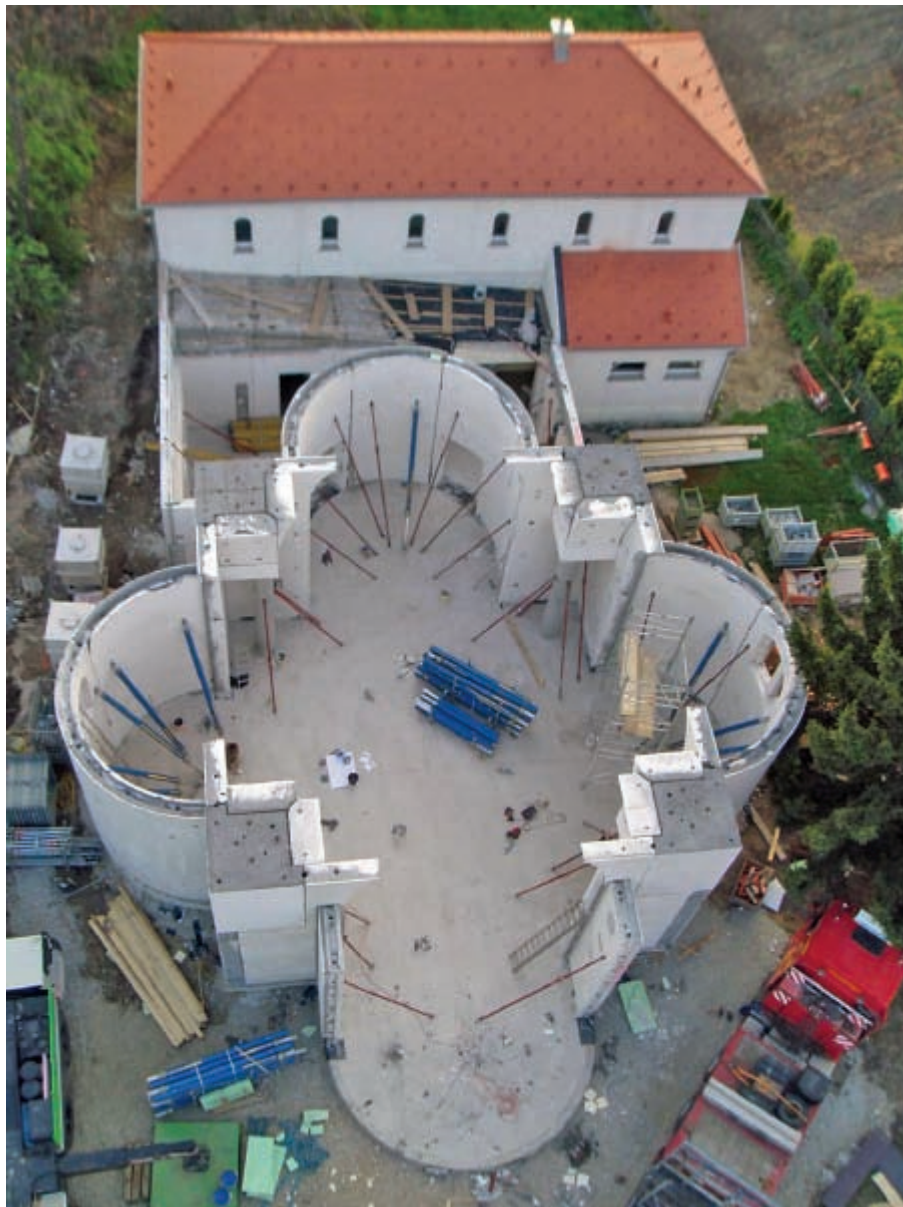
Rohbau von oben
