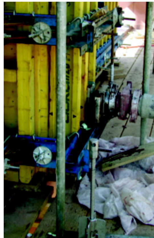
Doka-Trägerschalung Top 50 mit Einfüllstützen für selbstverdichtenden Beton
