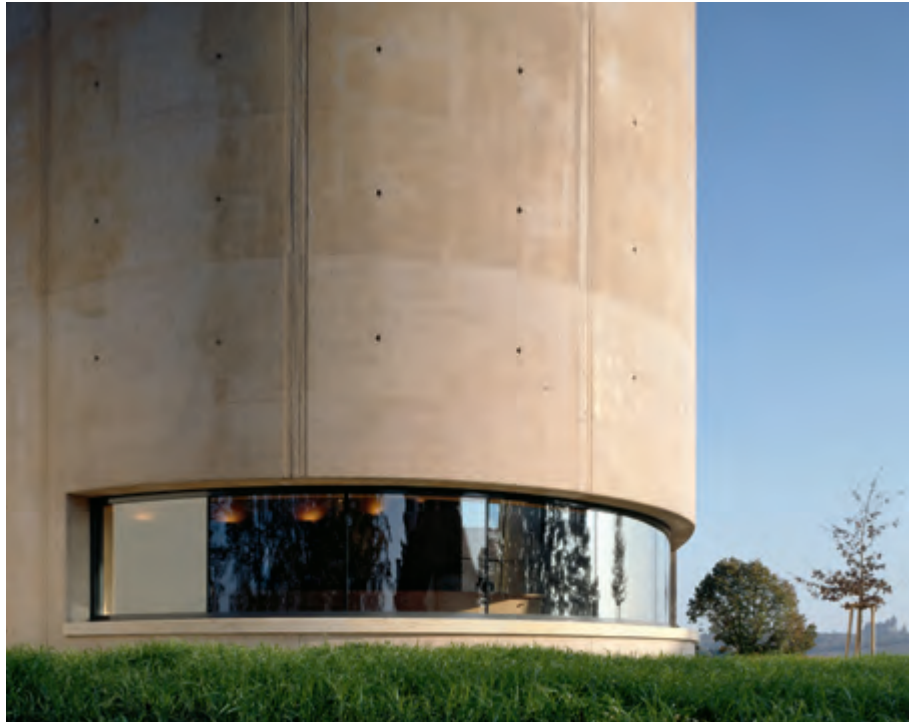
Kirche, Glockenturm und Sakristei von Süden
