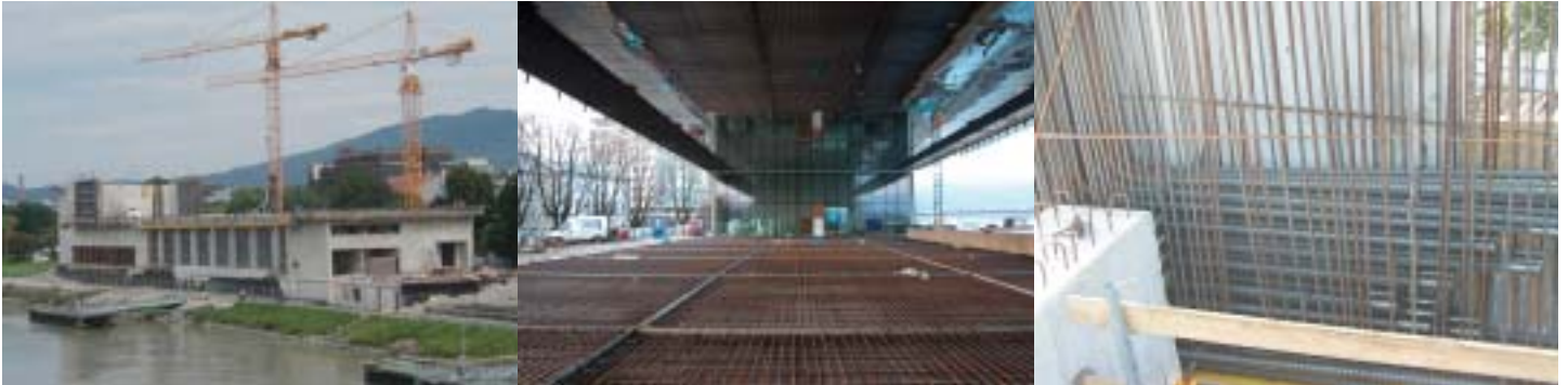
Fotos v.l.n.r.: Bauzustand, Skulpturenhalle, Trägeranschluss Gerbergelenk
