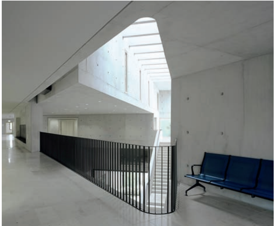
Wichtig für die skulpturale Gestaltung der Wände: Der Leichtbeton LB 15 musste Sichtbetonqualität aufweisen.
