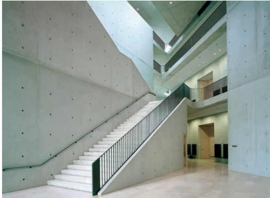
Sämtliche Fassadenbauteile des monolithisch konzipierten Entwurfs bestehen aus Leichtbeton.
