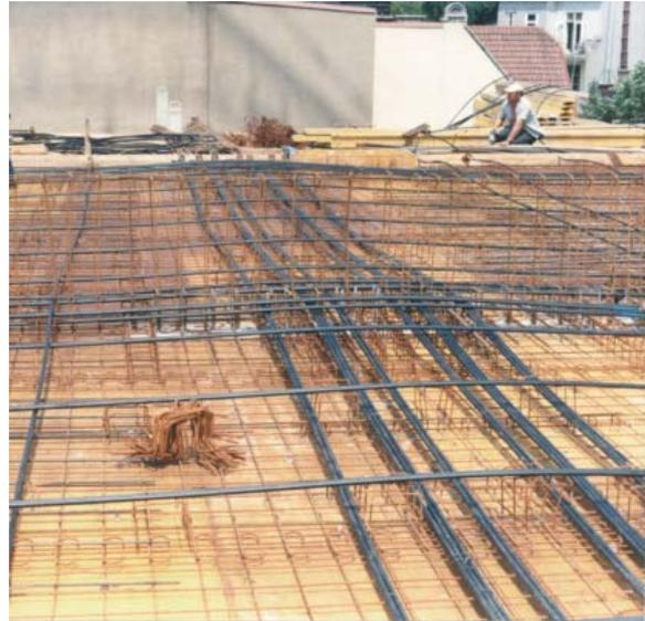
Abb. 5: Konventionelle Spanngliedführung mit Unterstellungen
