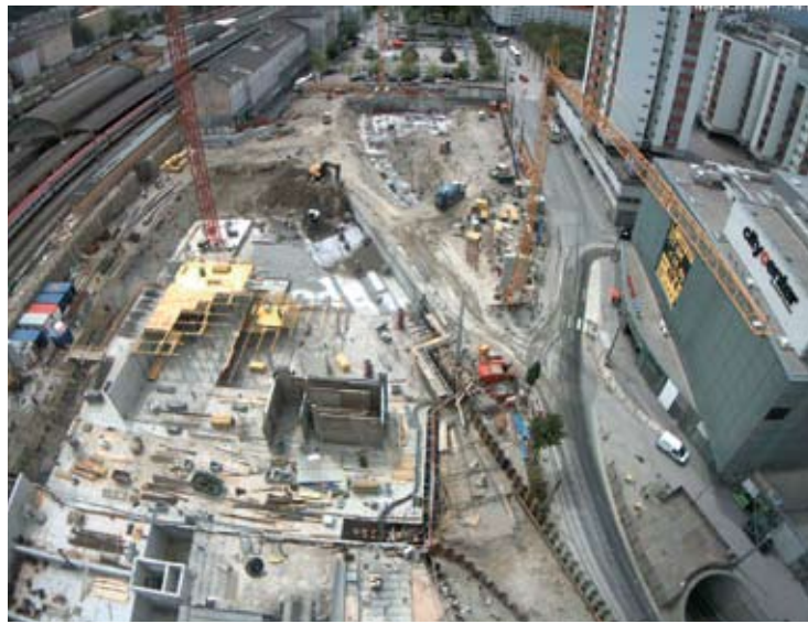
Aushub- und Rohbauarbeiten im Bereich EKZ, Hotel und Büro von der SGKK aus gesehen
