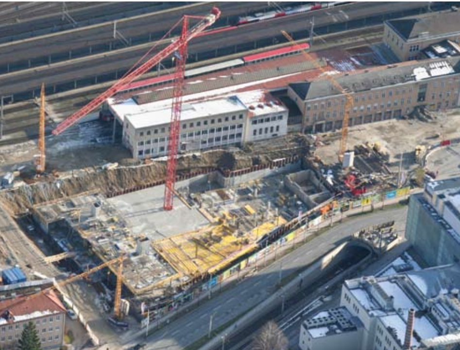
Aushub- und Rohbauarbeiten im Bereich SGKK von Westen fotografiert Foto: © Luftbildservice Redl
