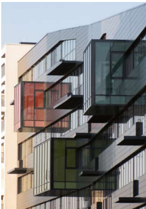
Bürogebäude: Westfassade mit Littexglaskuben
