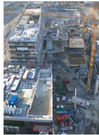
Rohbauarbeiten im Bereich EKZ und Hotel – 3,5 Monate vor Übergabe Hotel
