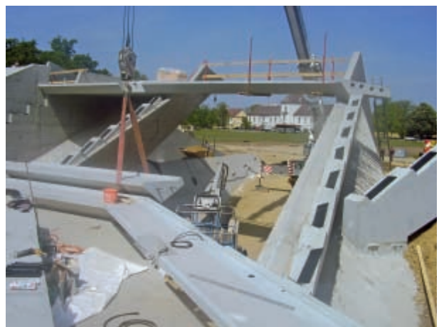
Abb. 9: Versetzen der Osttribüne
