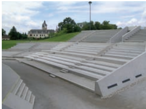
Abb. 11: Fertige Haupttribüne Oben und Unten sowie die Westtribüne
