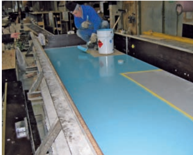
Abb. 4: Einstreichen jener Bereiche, die nach dem Betonieren gewaschen wurden
