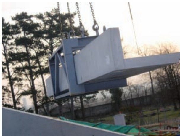
Abb. 8: „Versetzgabel“ zum Versetzen der Winkelstufen
