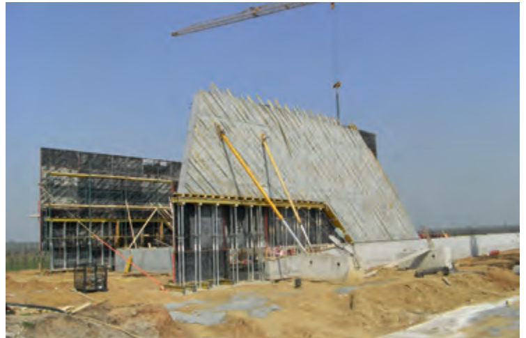
Aufbau der Sichtbetonwände
