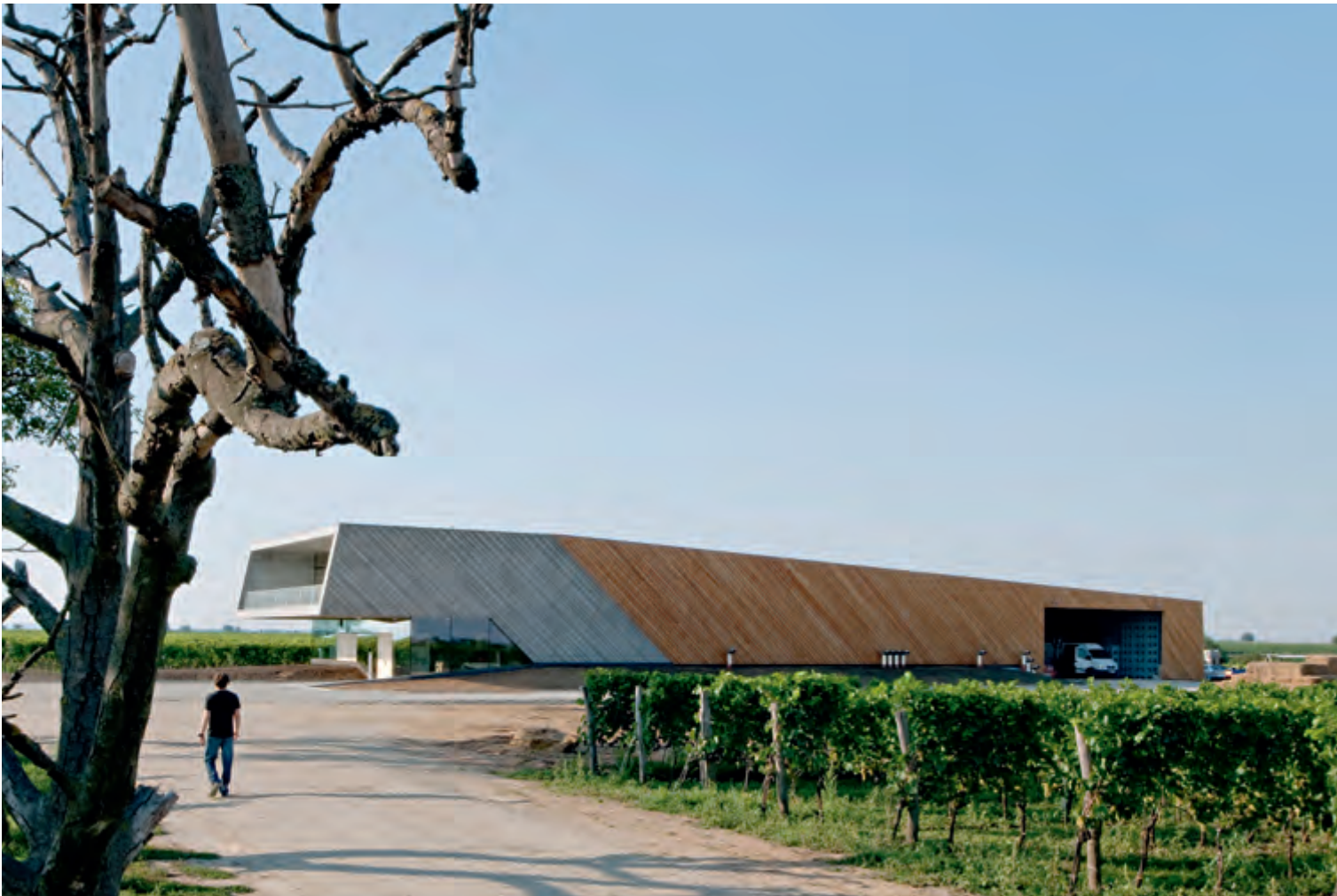
Blick zum Weingut am Goldberg (Ostfassade)
