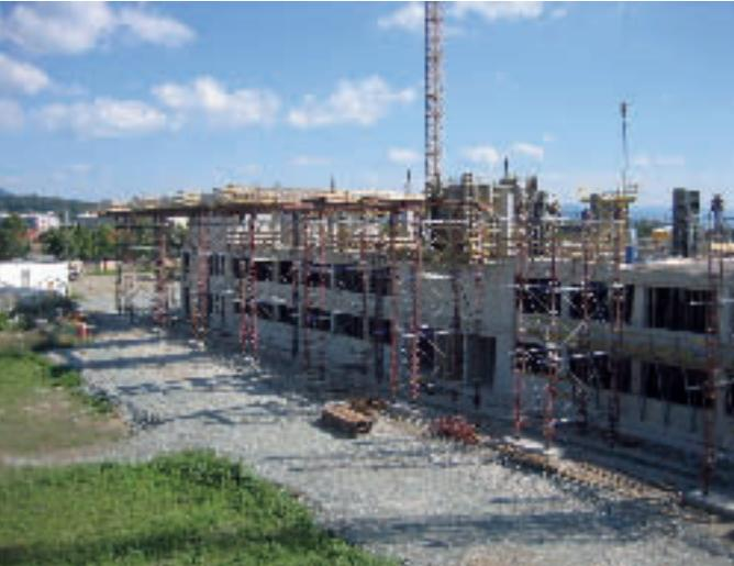
Westgebäude (Stadionaußenseite): Mit Rüsttürmen werden die auskragenden Ortbetonunterzüge für die VIP-Box betoniert.
