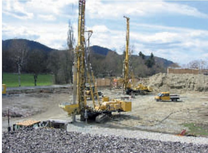
Bodenverbesserungsmaßnahmen: Durch die schwierigen Bodenverhältnisse mussten vor Baubeginn über 60.000 lfm Rüttelstopfsäulen eingebaut werden.
