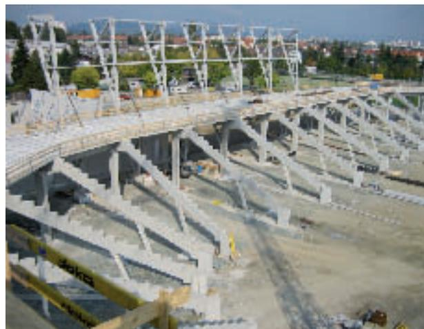
Blick unter die Verteilerebene: 42 gleichartige Gesperre aus Ortbetonstützen und Fertigteilträgern tragen später die Verteilerebene und die Tribünenstufen des Unterranges.
