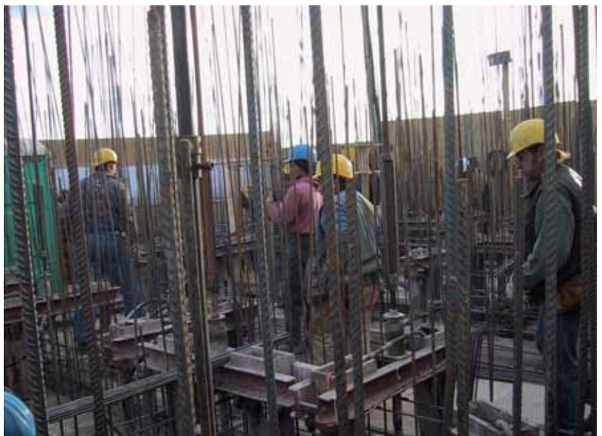
Die Lieferung des Gleitbetons in entsprechender Güte und Konsistenz wurde vom Betonlieferanten Wopfinger Transportbeton Ges.m.b.H. in Zusammenarbeit mit der Gleitbau Ges.m.b.H. Salzburg und dem bauausführenden Unternehmen auf die speziellen gleitbautechnischen Anforderungen abgestimmt. Der Beton sollte innerhalb von sieben Stunden seine Grundfestigkeit erreichen. Vom anliefernden Werk wurde verlangt, eine allfällige erforderliche Zementumstellung in maximal fünf Stunden zu ermöglichen.
