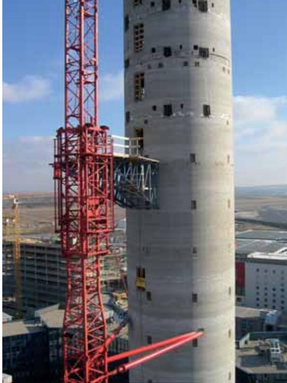
Vor Beginn der Gleitarbeiten ging man von einer Zielleistung von 3,40 m pro 24 Stunden aus. Rückblickend konnte eine durchschnittliche Tagesleistung von 3,75 m festgestellt werden, wobei bei der Errichtung der Mittelgeschoße, die weniger Aussparungen und Einbauteile aufweisen mussten, Spitzenleistungen von bis zu 4,60 m pro 24 Stunden erreicht werden konnten.
