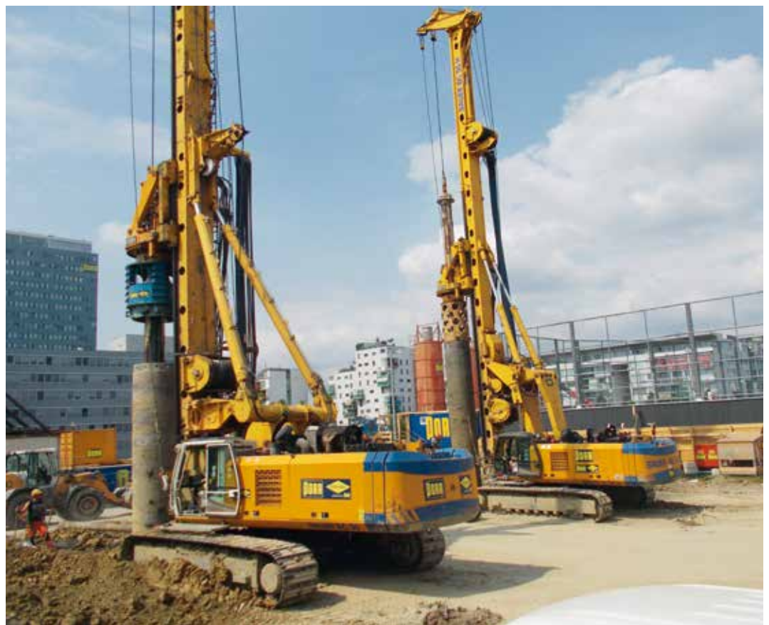
Bohrpfahlerstellung
