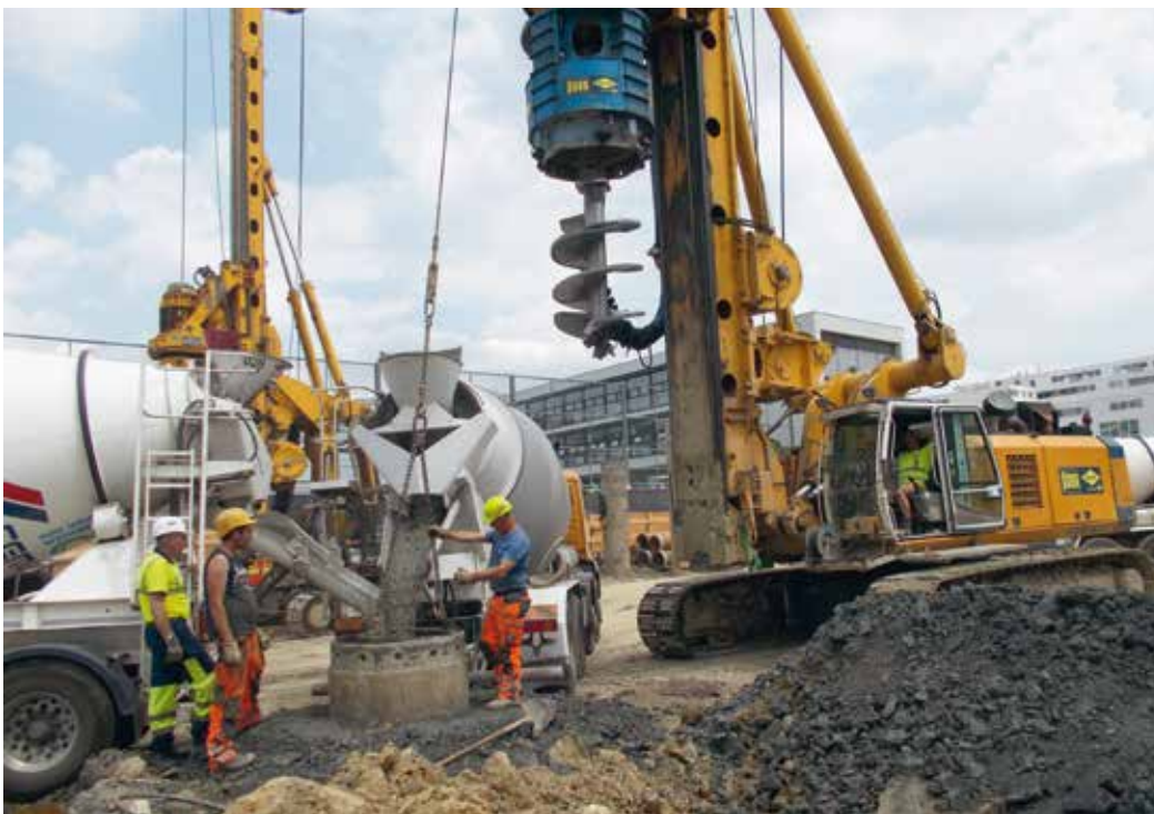
Betoneinbau Bohrpfahl
