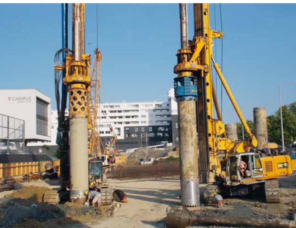
Bohrfahlherstellung
