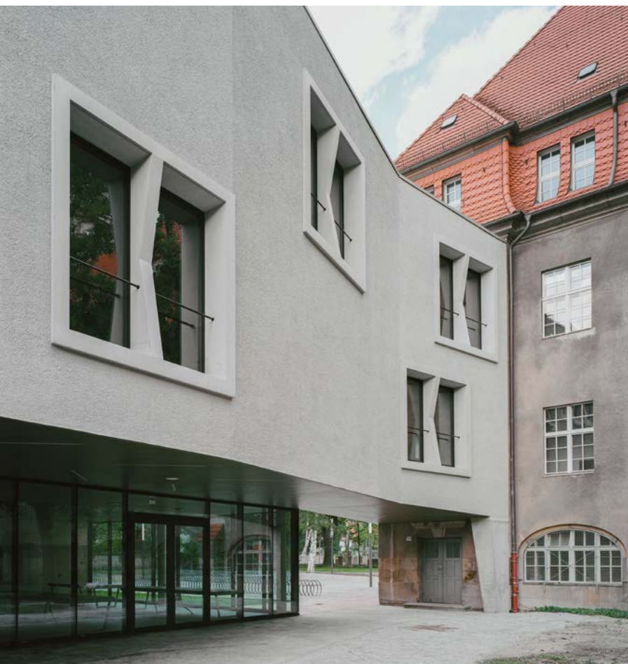
Mit einem Knick zum Altbau – die Erweiterung des Arndt-Gymnasiums zeigt Respekt gegenüber der Ehrwürdigkeit des Altbaus.
