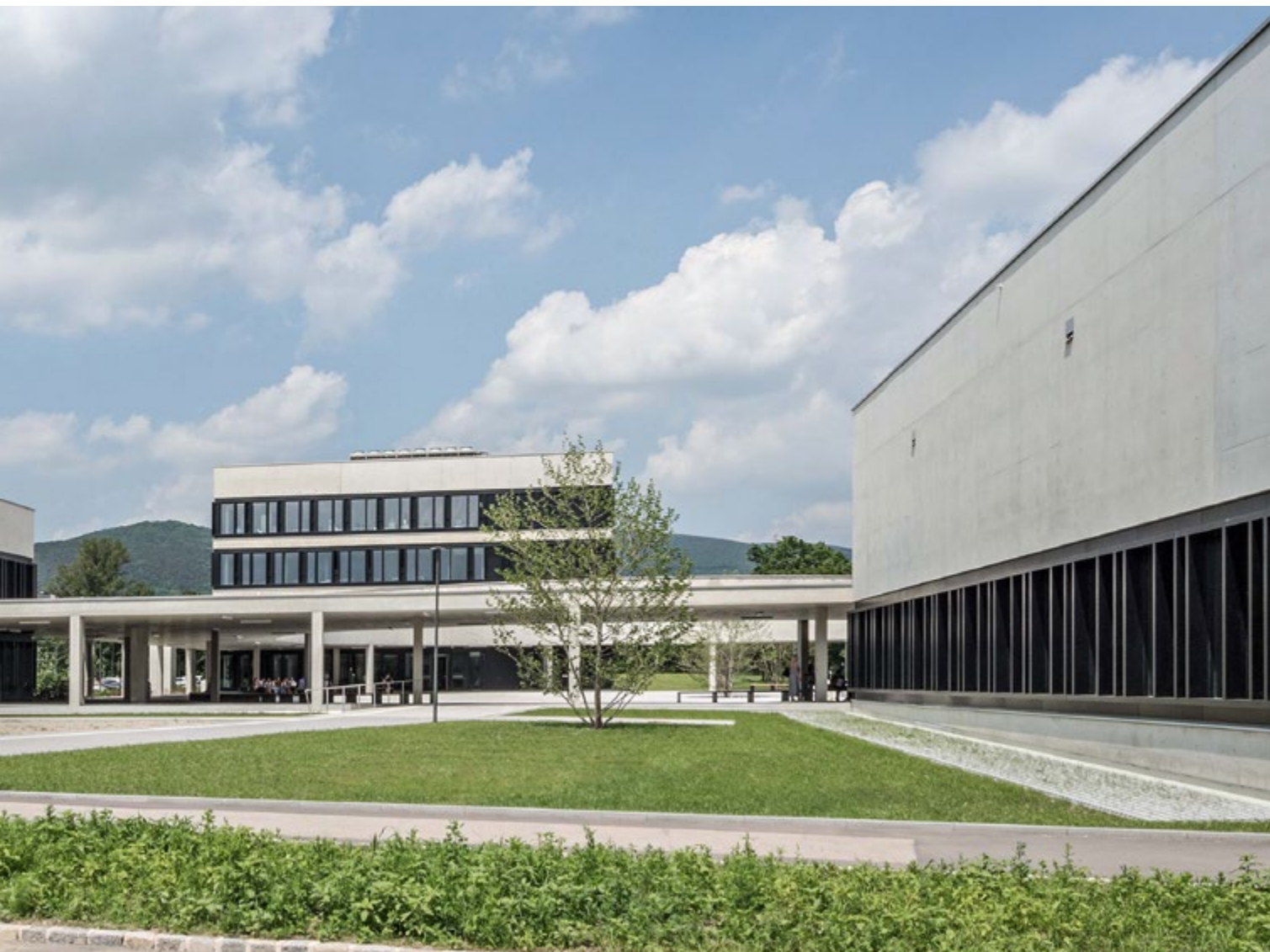
Bauteilaktiviert, Sichtbeton und offene, freundliche Atmosphäre – so zeigt sich die Pädagogische Hochschule Baden, die neu gebaut wurde.
