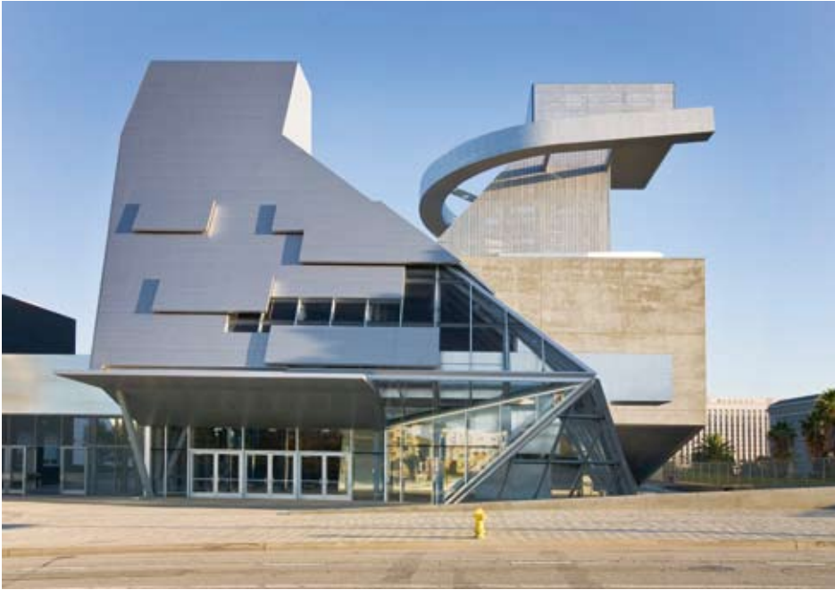
Blick zum Theaterfoyer und dem Turm
