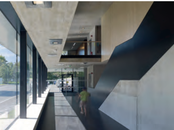
Glasfront, Sichtbetondecken und schwarz eingefärbter Betonboden
