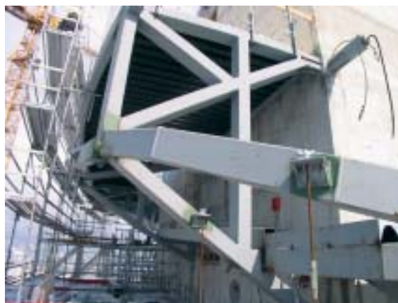
Andocken des Stahlkopfes an den Betonturm
