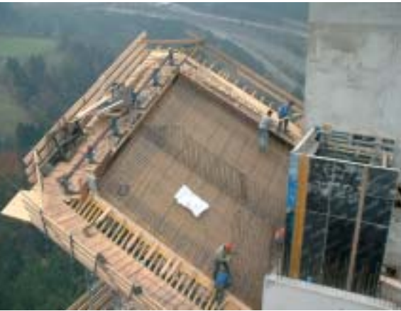
Auskragende, schräge Bodenplatte des sog. Rucksackes
