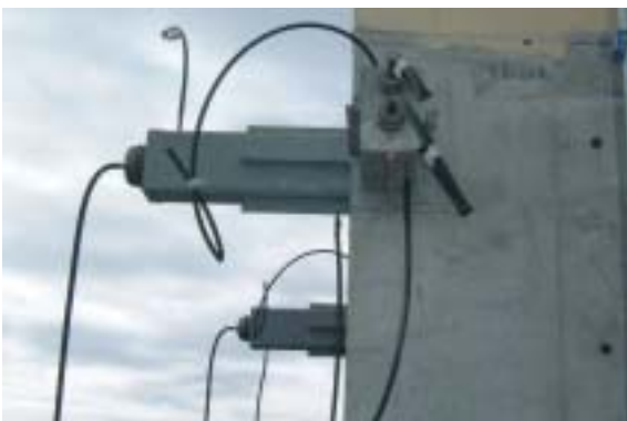
Andockelemente für die Stahlrohrkonstruktion
