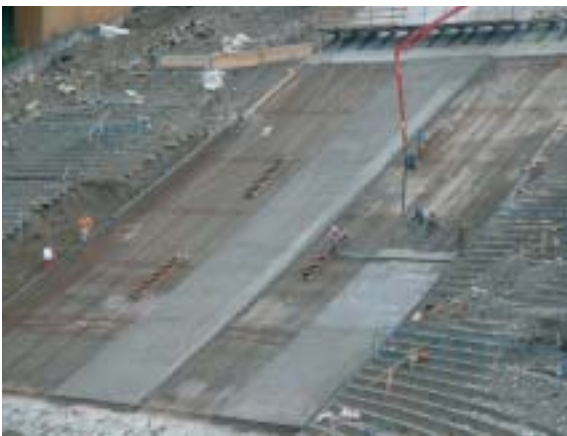
Befestigungsmaßnahmen am Aufsprunghügel Foto: ARGE Bergisel
