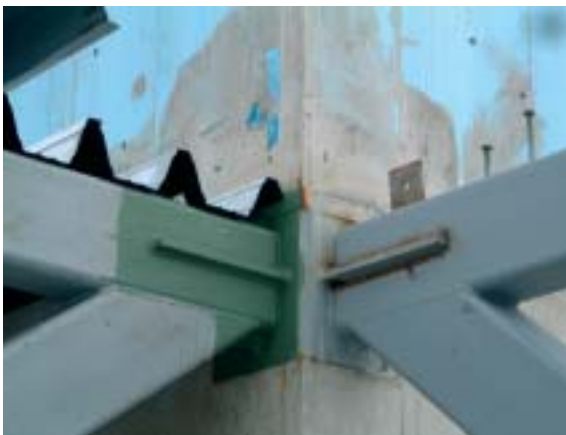
Andockelemente für die Stahlrohrkonstruktion
