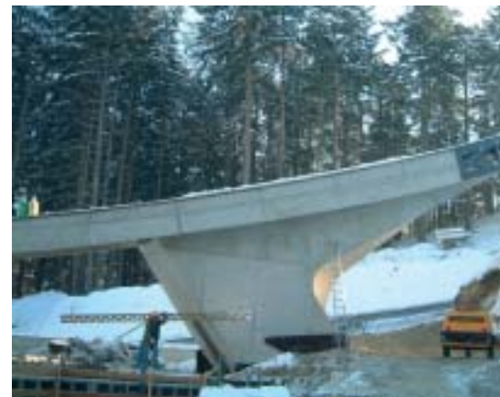
Absprungbauwerk in Form eines Knies
