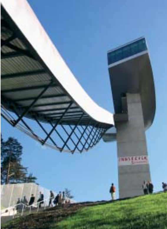
Seilunterspannter Stahlfachwerkträger
