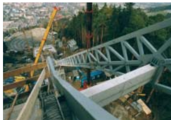
Vorgespannter Konsolenträger zur Lagerung der Anlaufspur
