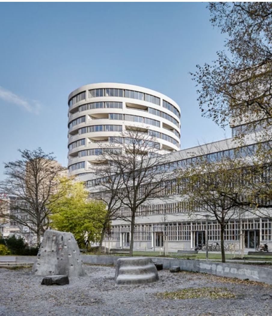
Blick vom Heiligfeld-Park: vorn das aufgestockte Werkstattgebäude, dahinter der neue Turm, der den Rampenbau überragt.
