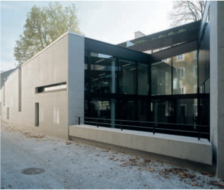
Ansicht Steingasse, Haus A
