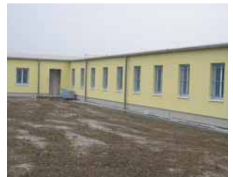
Abb. 10: Innenhof vor Fertigstellung
