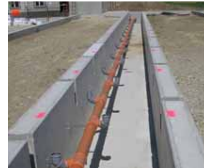
Abb. 7: Fundament, Kollektorgang
