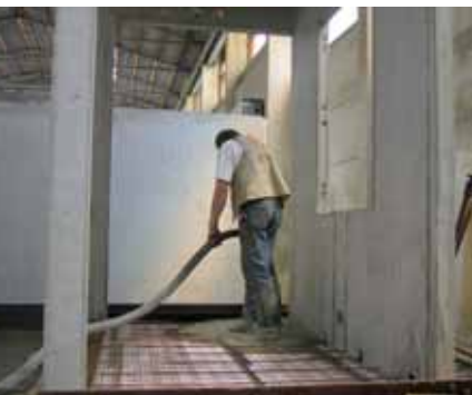
Abb. 2: Bodenherstellung mit Fließbeton
