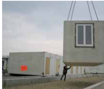
Abb. 6: Versetzen der Haftmodule
