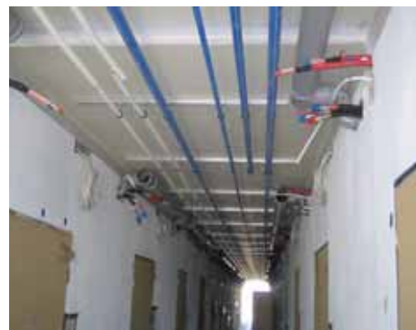
Abb. 9: Anbindung der Versorgungsleitungen, Wasser, Heizung
