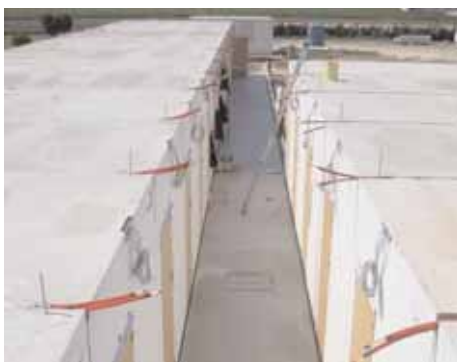
Abb. 8: Mittelgang zwischen den Haftzellen
