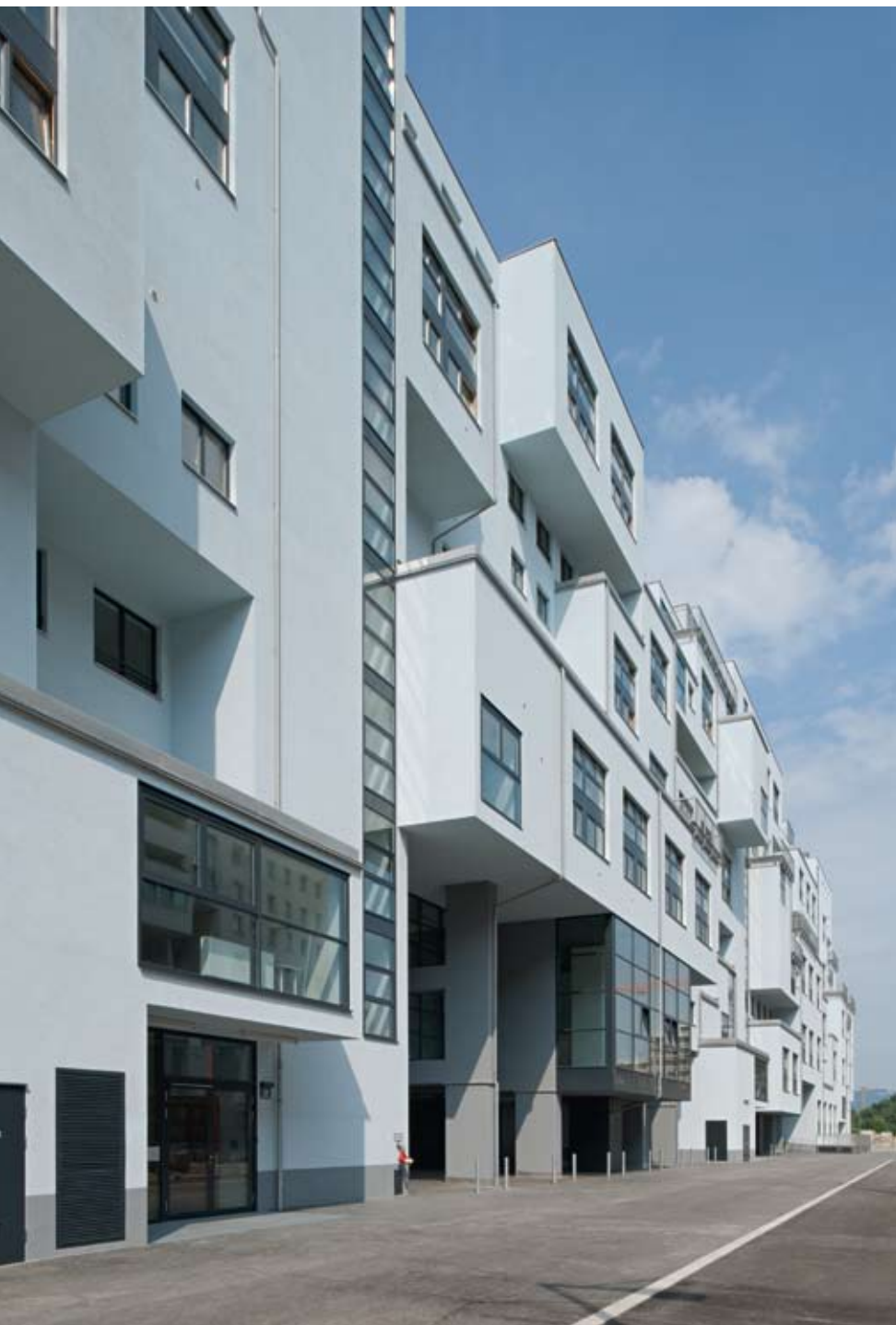
Straßenfassade: Die doppelt großen Verglasungen der Maisonnetten spielen mit dem Maßstab des Hauses. Sind es 5 oder 10 Geschosse?
