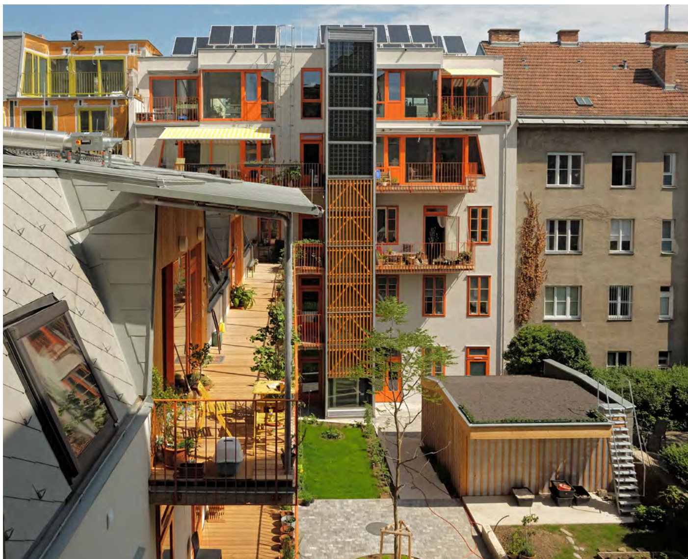
Startzelle Smart Block Geblergasse Nr.11+13 Hofansicht
