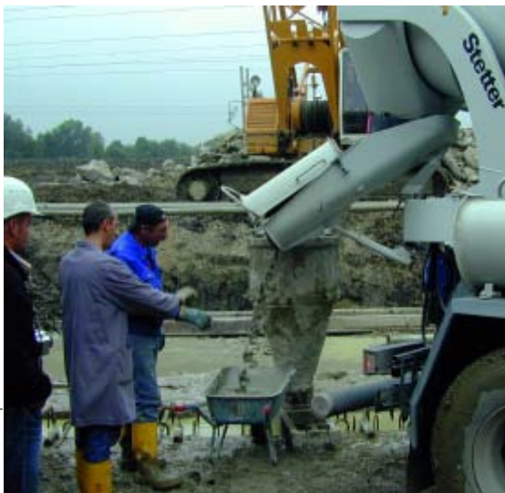
Bild 1: Entnahme des Betons an der Einbaustelle
