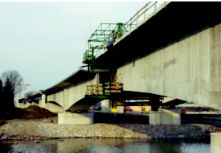
Ennsbrücken im Dezember 2003 Tragwerksbeton: C50/60/B4/W55/NA6/A1,5
