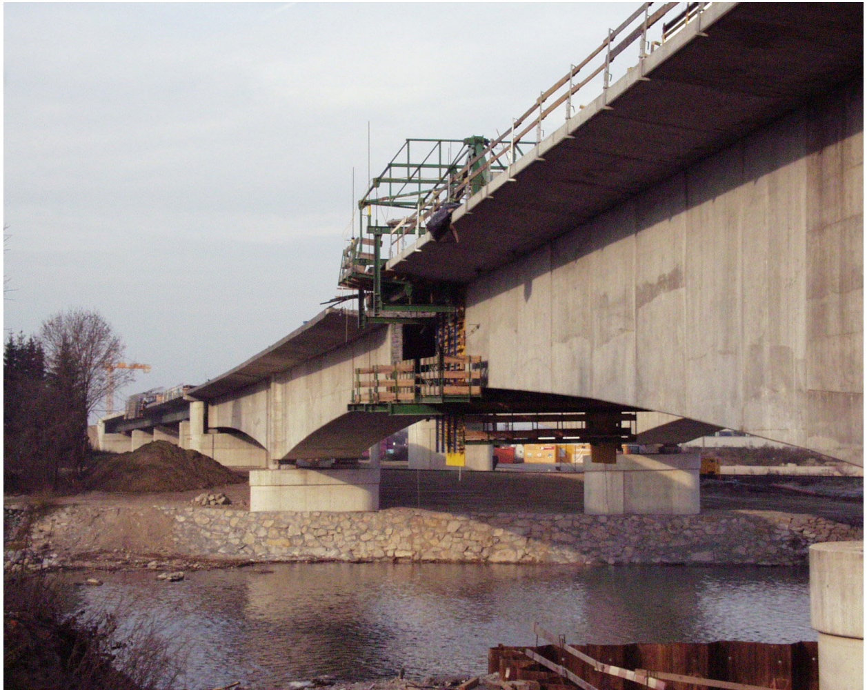
Foto: Ennsbrücken im Dezember 2003. Tragwerksbeton: C50/60/B4/W55/VA6/A1,5
