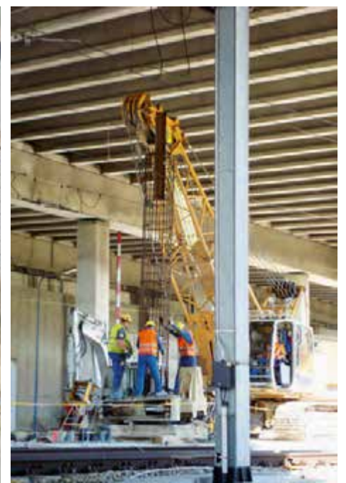
Bohrpfahlerstellung
