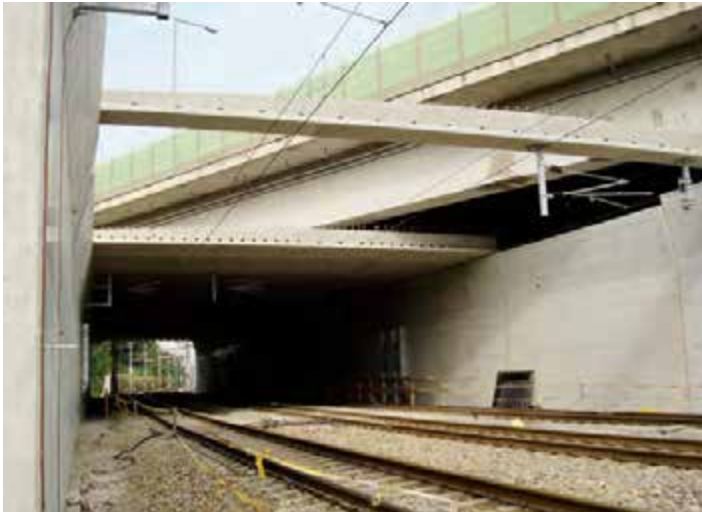
Bauweise mit Halbfertigteilen
