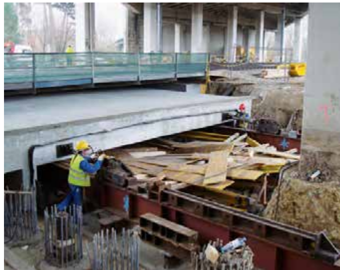
Einschieben Tragwerk unter Hilfsbrücke
