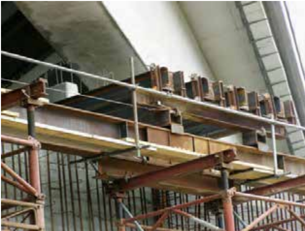
Einschieben Fertigteile
