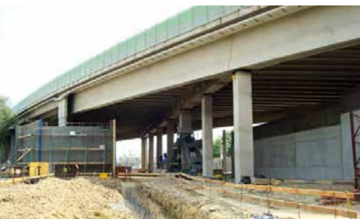
Abfangung Bestandsstütze mit Stahlsprengwerk
