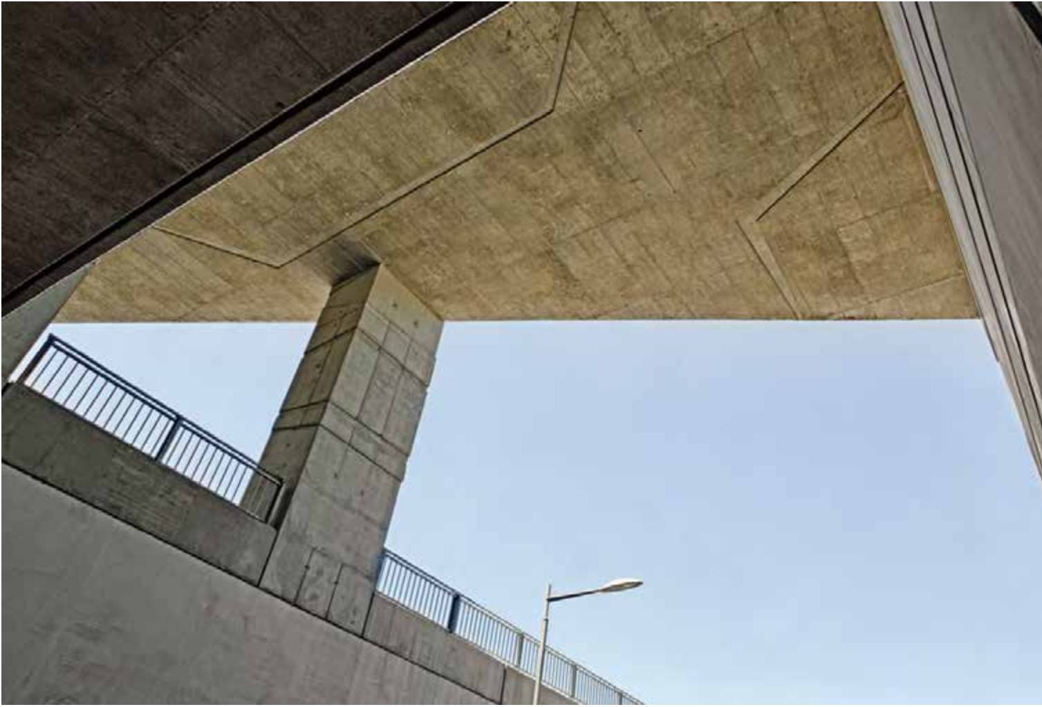
Gestaltete Betonoberfläche
