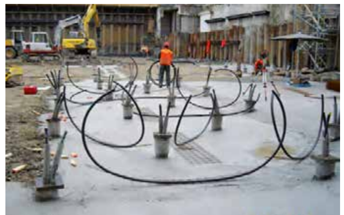
In die Pfähle eingebrachte Geothermieleitungen
