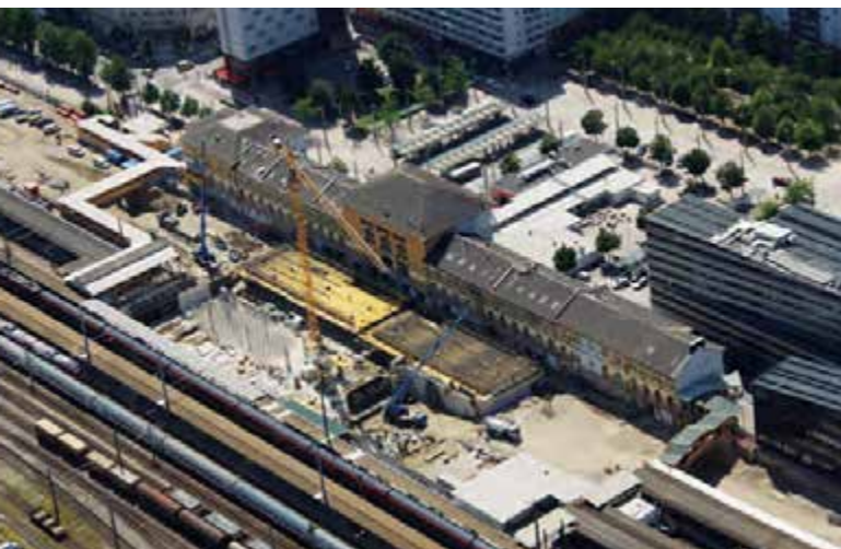
Blick auf die Gleisstragwerke im Bau
