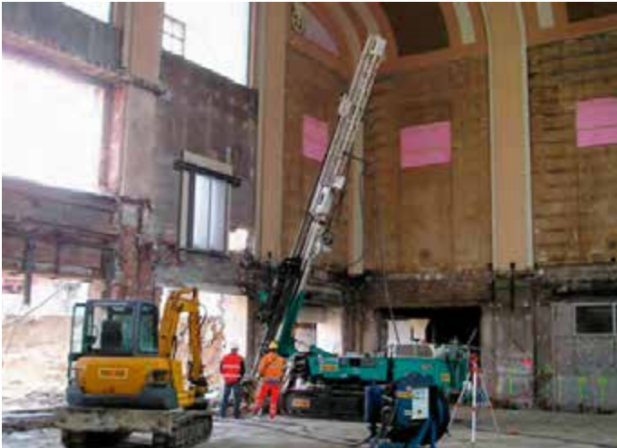
Düsenstrahlverfahren im Inneren des denkmalgeschützten Aufnahmegebäudes
