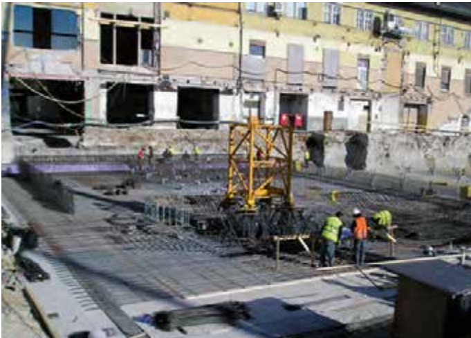
Bodenplattenabschnitt der „Weißen Wanne“ im Anschluss an den Bestand
